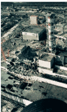
Ausmaß der Zerstörung von Block 4 in Tschernobyl (Quelle: GRS, www.grs.de )
