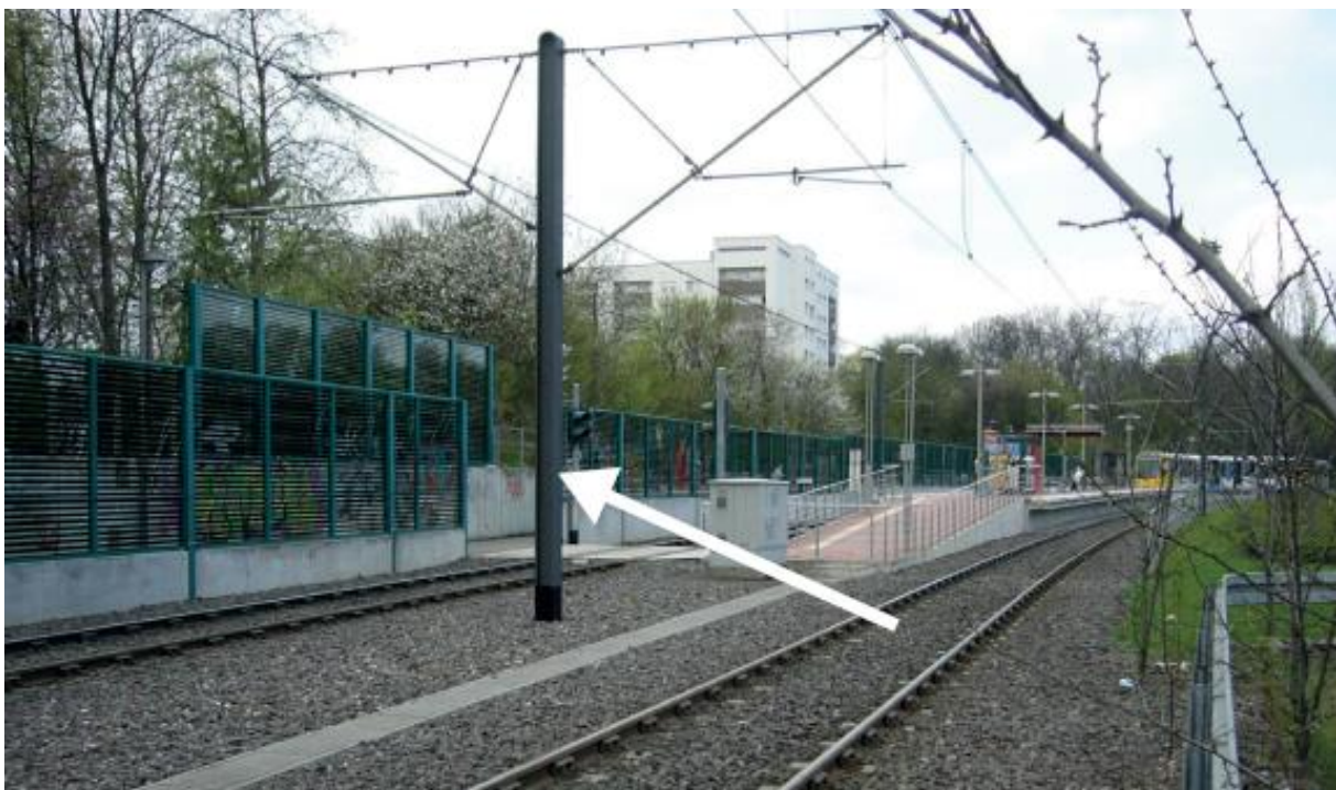
Abbildung 64: Beispiel für eine Schallschutzwand aus Glas auf Betonsockel
