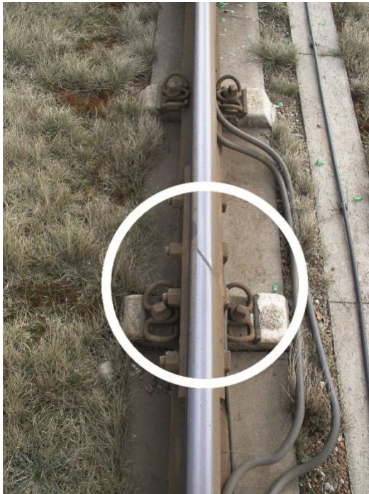
Abbildung 52: Beispiel für die Anwendung schräger Schienenstöße – Beispiel Straßenbahn Stuttgart
