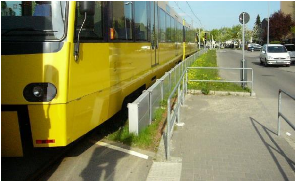
Abbildung 67: Einsatz einer niedrigen Schallschutzwand neben einem Straßenbahngleis – Beispiel Straßenbahn Stuttgart
