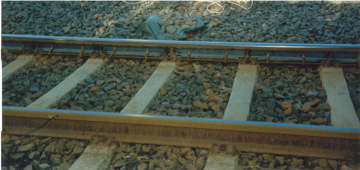
Abbildung 48: Beispiel für Schienenstegdämpfung, Befestigung mit Klammern
