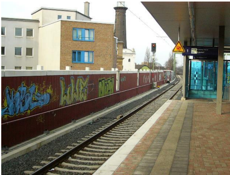
Abbildung 63: Beispiel für eine Schallschutzwand aus Aluminium
