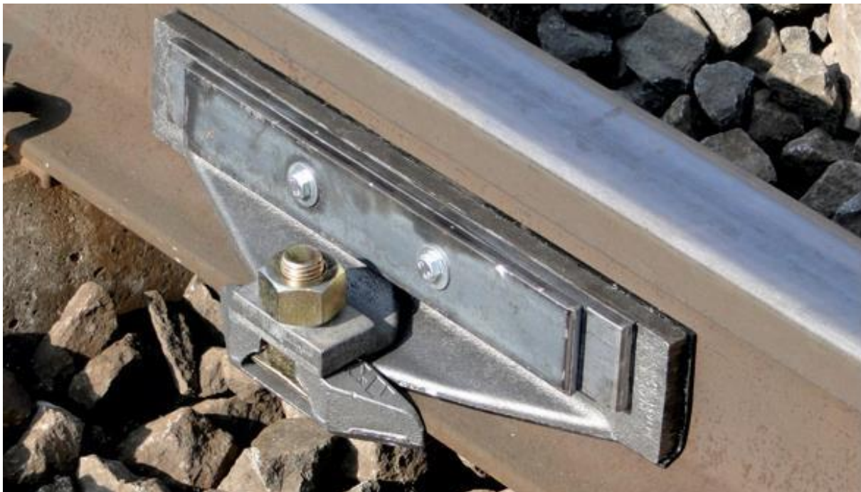
Abbildung 47: Beispiel für einen Schienenstegdämpfer
