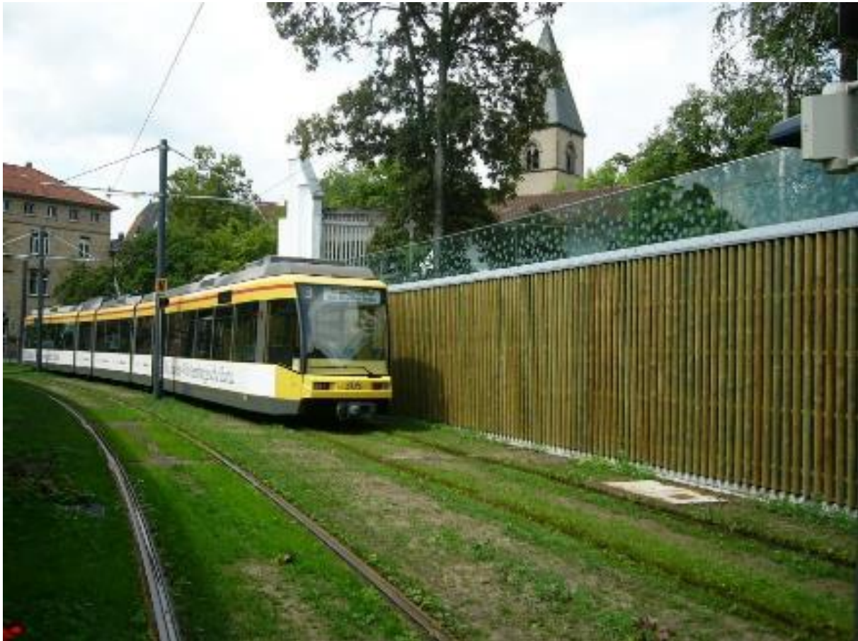
Abbildung 65: Einsatz einer hohen Holz-Glas-Schallschutzwand – Beispiel Karlsruhe
