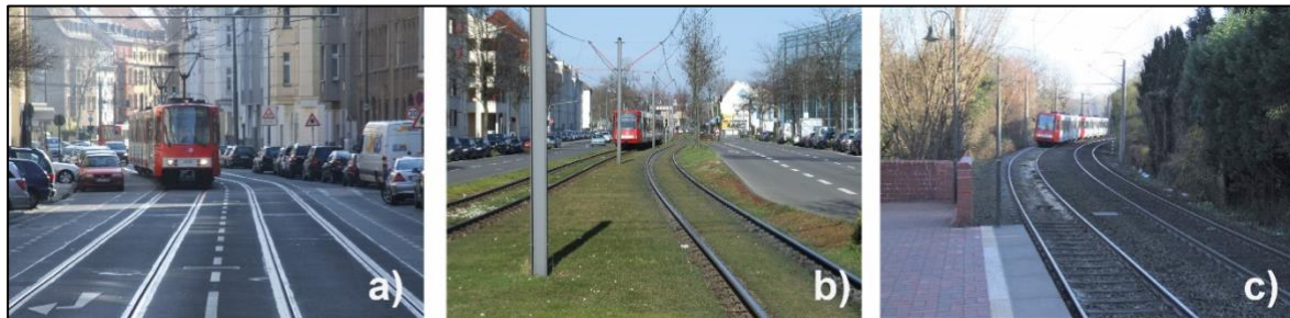
Abbildung 1: Bahnkörper der Straßenbahn
