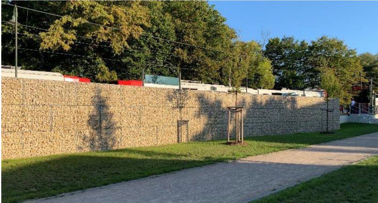
Abbildung 66: Gabionenwand an einer Straßenbahnstrecke im Bereich einer Haltestelle
