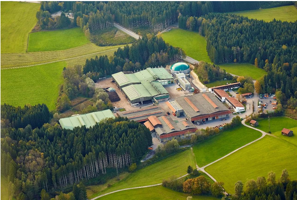
Abbildung 69: Luftbild Bioabfallbehandlungsanlage Quarzbichl
