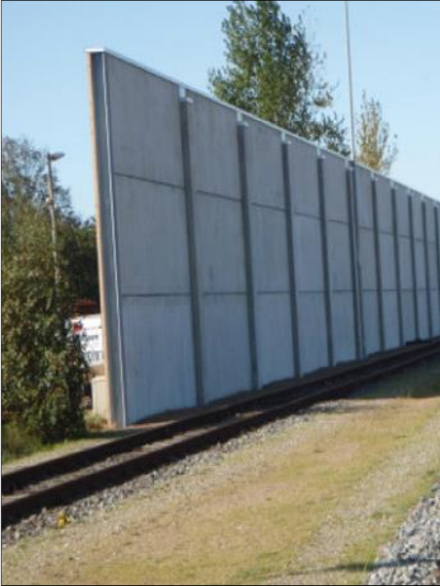
Abb. 46: Betonwand, 6,20 m hoch
