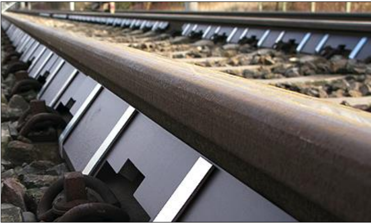
Abb. 50: Schienenstegabschirmung
