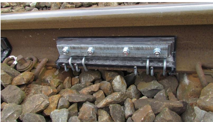
Abb. 49: Schienenstegdämpfer
