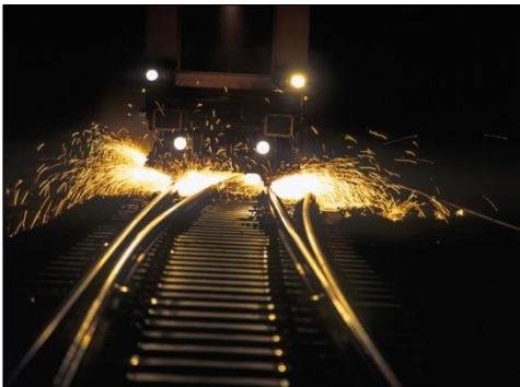
Abb. 43: Schienenschleifen
