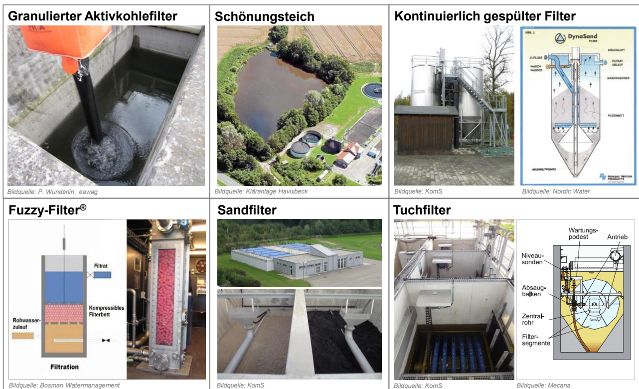
Abbildung 46: Geeignete Verfahren zur Nachbehandlung bei einer 4. Reinigungsstufe
