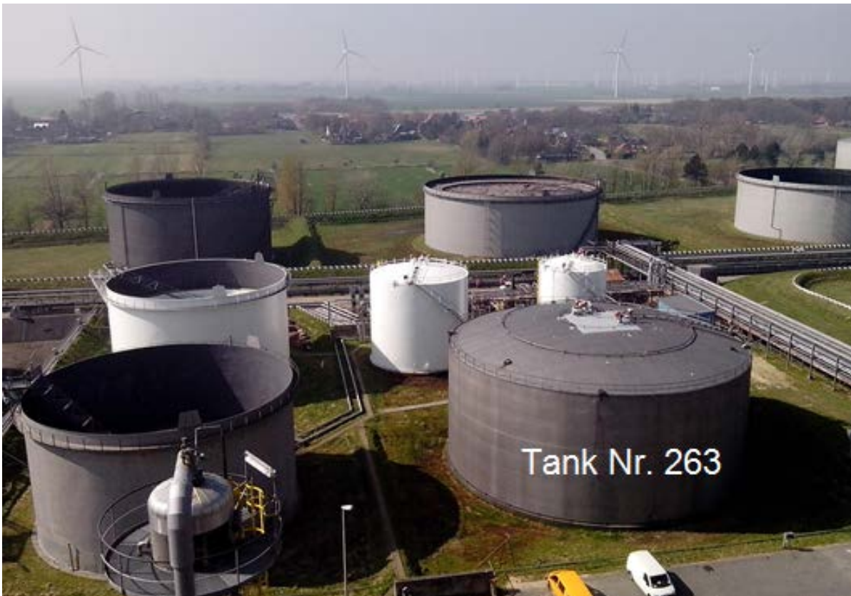
Abbildung 150: Ansicht des Tanks Nr. 263
