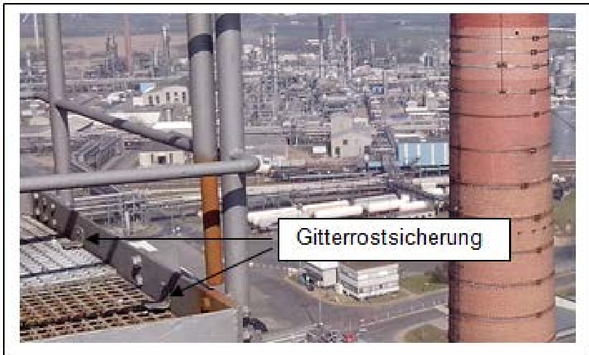
Abbildung 145: Sicherung von Gitterrosten
