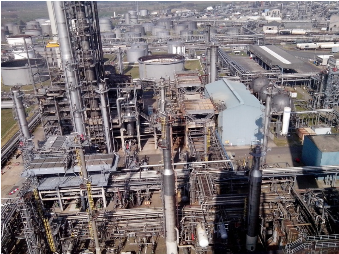
Abbildung 143: Gastrennung (Vordergrund) mit Platformer (Hintergrund) g
