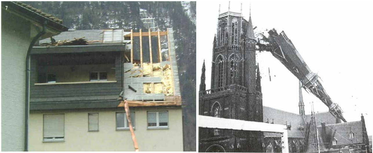
Abbildung 51: Windschäden an einzelnen Bauteilen sowie am Gesamttragwerk
