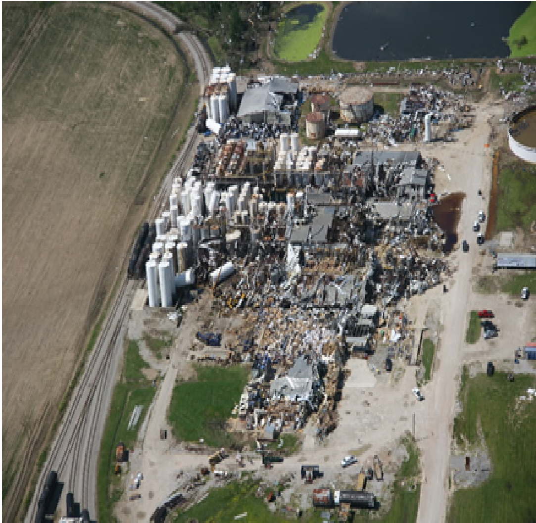
Abbildung 173: Schäden von Anlagenteilen eines Chemieunternehmens in den USA nach einem F3 Tornado
