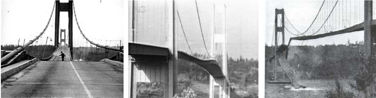
Abbildung 55: Sturmschäden durch Flatterschwingungen
