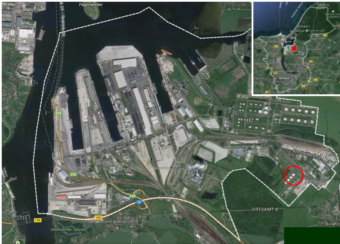
Abbildung 158: Lage des Großtanklagers-Ölhafen Rostock GmbH
