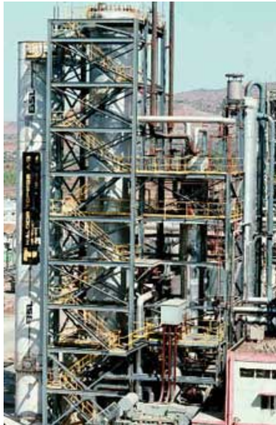
Abbildung 121: Eingerüsteter Reaktor einer Ammoniaksyntheseanlage
