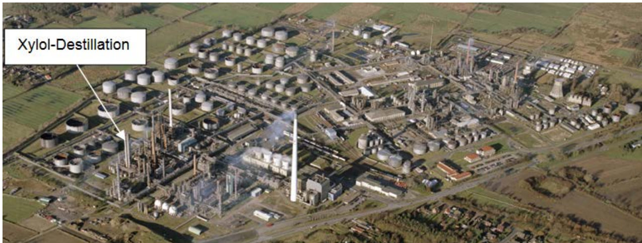
Abbildung 127: Gesamtansicht des Betriebsstandortes mit der Xylol-Destillation
