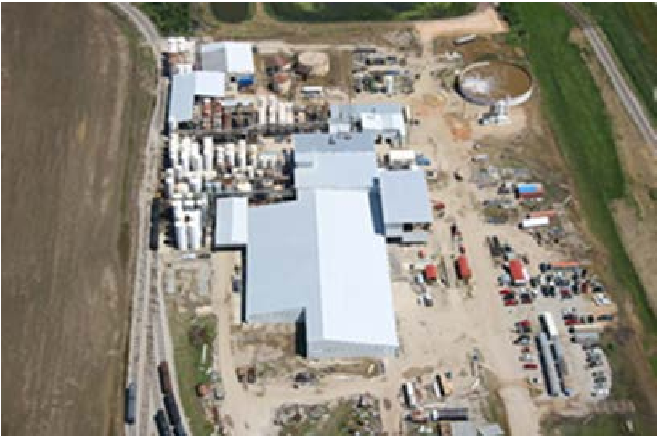
Abbildung 177: Chemieunternehmen in den USA nach einem F3 Tornado und Wiederaufbau
