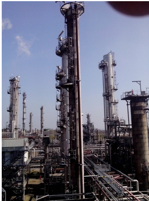
Abbildung 122: Freistehende Kolonnen in einer Raffinerie
