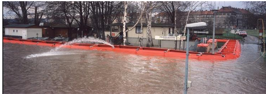
Anhang 4 Abb. 12: Beispiel für ein offenes Behältersystem
