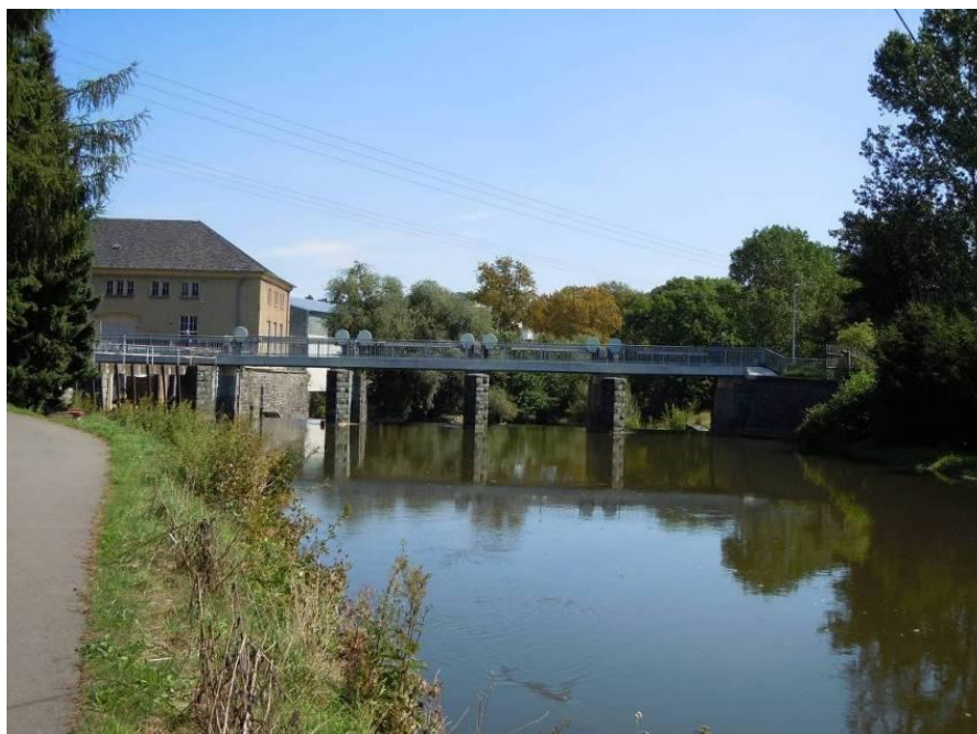
Anhang 6, Abb. 9: Wehr oberhalb des Werksgeländes (Blick in Fließrichtung des Wassers)
