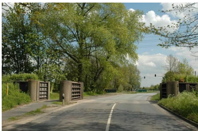
Anhang 4 Abb. 5: Hochwasserschutztor eines Betriebsbereichs
