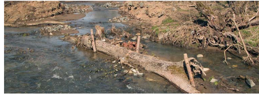
In einen Mittelgebirgsbach wurde Totholz eingebracht, um die Sohle zu strukturieren.
