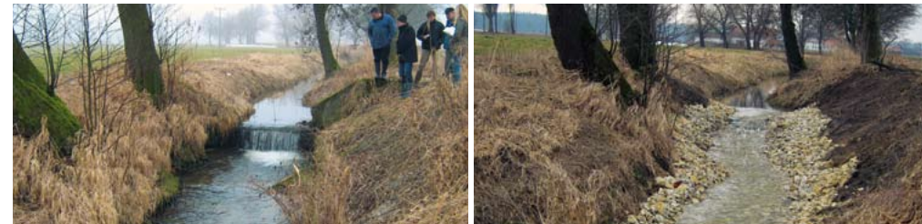
Im Rahmen eines Gewässerentwicklungskonzeptes wurden in diesem Bach sechs Sohlrabstürze in flache und biologisch durchgängige Sohlrampen umgebaut.
