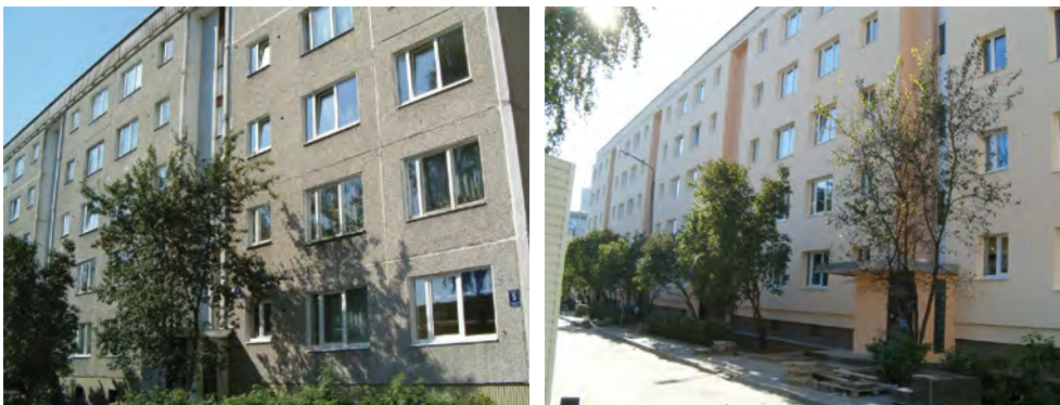
Abbildung 5: Sanierungsprojekt Riga, Celmu Str. 5 vor und nach der Sanierung
