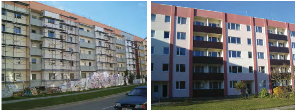
Abbildung 6: Wohngebäude Skolas Str. 21, Broceni während und nach der Sanierung
