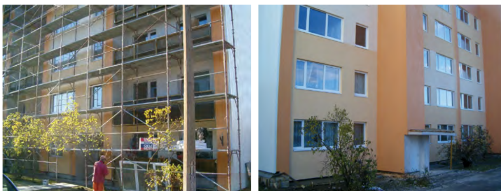
Abbildung 7: Wohngebäude Lielcieceris Str. 34, Broceni während und nach der Sanierung
