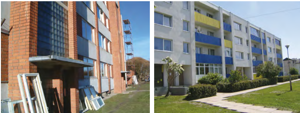
Abbildung 9: Wohngebäude Tirgus Str. 3, Salacgriva vor und nach Sanierung
