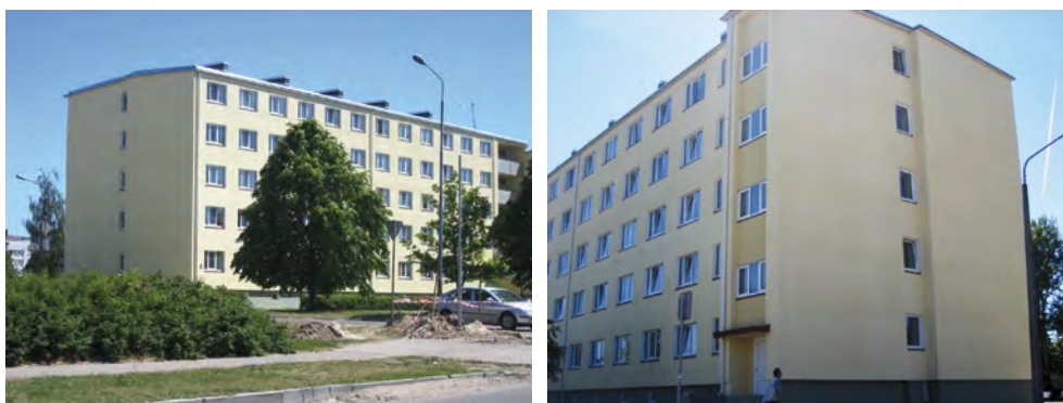
Abbildung 8: Wohngebäude Ganibu Str. 135/141, Liepaja nach Sanierung
