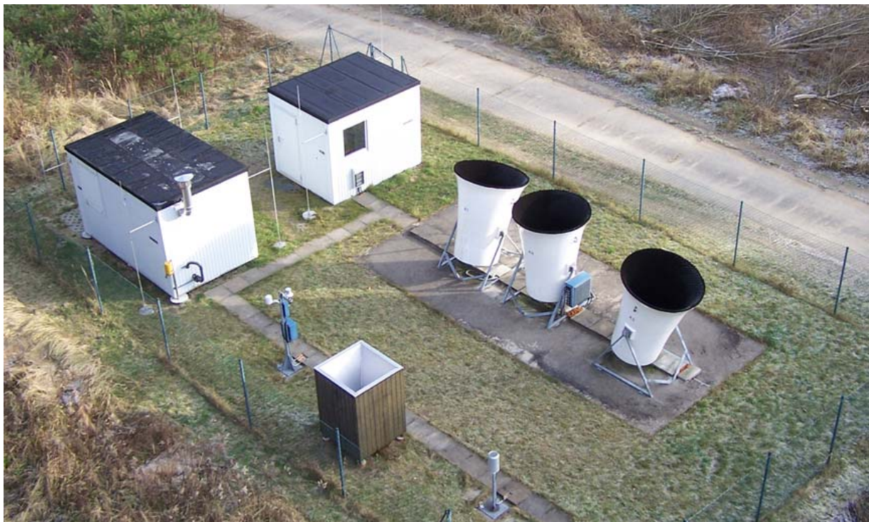
Abb. 4: Meteorologisches Messfeld mit Immissionsmessstation IMC4
