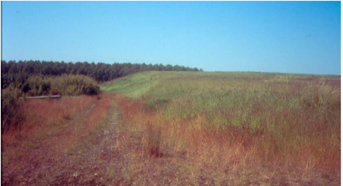
Abbildung 8: Sanierte und rekultivierte Phosphatgipsdeponie Nordenham zum Zeitpunkt der Messungen (Blick von Grundwasser-Entnahmestelle PB 5 entlang des Haldenfußes über den Räumweg)
