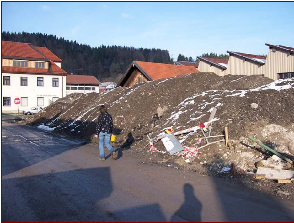
Abbildung 44: Kleine Halde in Hausham (Wohnsiedlung); Bodenaushub für Neubauten
