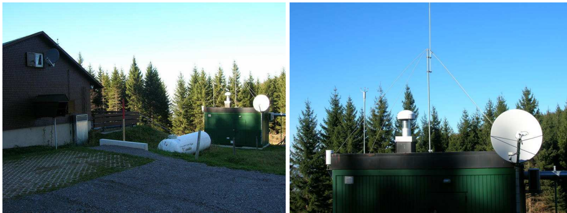
Abbildung 3.8: Die Station Schauinsland des Bundesamts für Strahlenschutz. Rechts ist der Messcontainer für die CTBTO-Messungen zu sehen, links das Stationsgebäude. Im rechten Bild (Nahaufnahme des Containers) erkennt man den Luftansaugstutzen in der Mitte und links davon ein Ultraschallanemometer. Der Blick ist in etwa nach Norden gerichtet.
