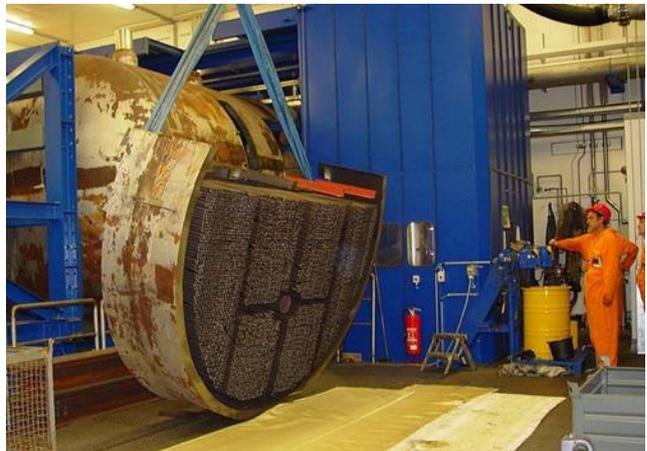
Abbildung D-19: Bildserie zur Ausschleusung und dem Abtransport des Dampferzeugers aus dem Kernkraftwerk Stade
