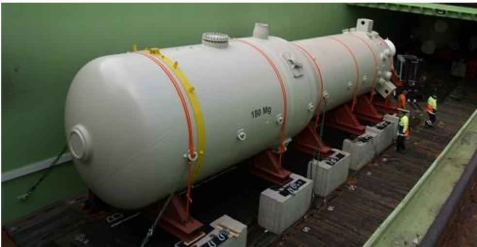
Abbildung D-20: Abtransport des Dampferzeugers aus dem Kernkraftwerk Obrigheim (Bildrechte: EnBW)
