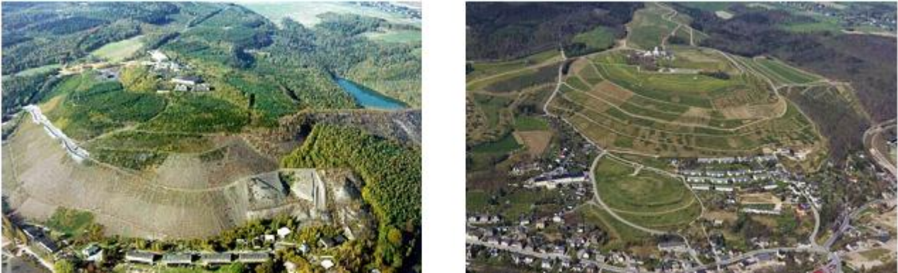
Abb. 7: Halde 38neu (Standort Schlema) vor und nach der Sanierung
