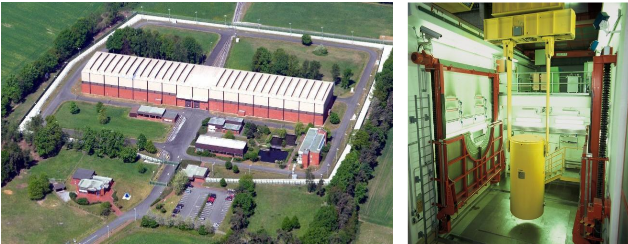
Abbildung G-2: Transportbehälterlager Ahaus (Bildrechte: GNS)
