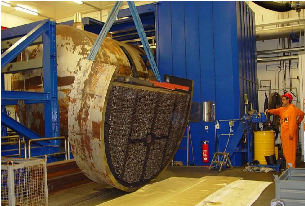
Abbildung D-20: Zerlegung eines Dampferzeugers durch Sägeverfahren im ZLN (Bildrechte: EWN)
