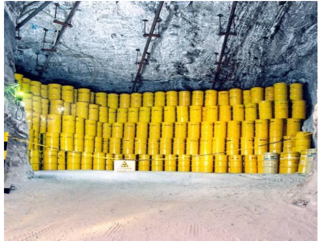
Abbildung D-14: Endlager für radioaktive Abfälle Morsleben (ERAM) (links: Luftbild, rechts: Einlagerungskammer mit gestapelten Fässern schwach radioaktiver Abfälle) (Bildrechte: BfS)
