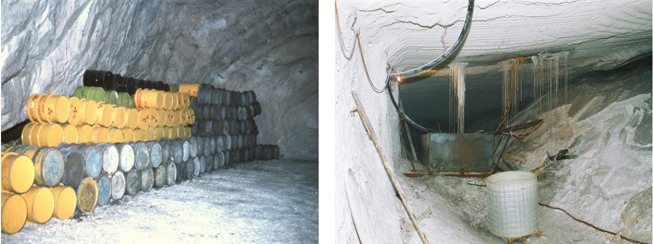
Abbildung D-13: Endlager Schachtanlage Asse II (links: Kammer bei der Einlagerung, rechts: Tropfstelle (vgl. die Ausführungen in H.6.9)) (Bildrechte: BfS)
