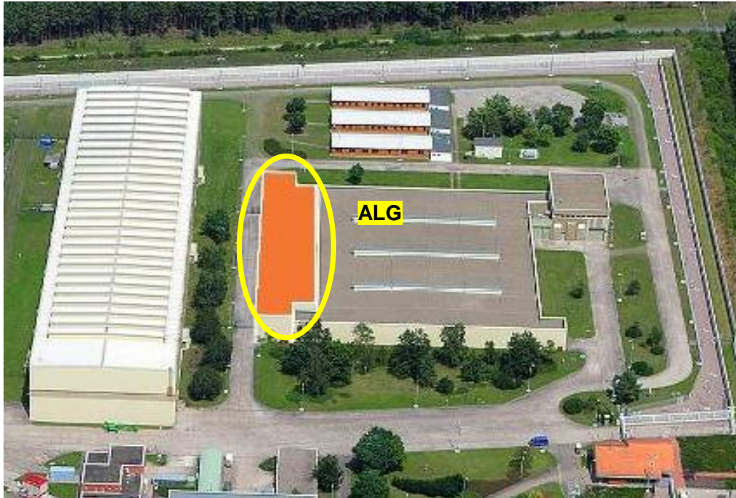
Abbildung D-12 : Geplanter Anbau an das Abfalllager Gorleben (ALG) zur Aufnahme der für die Erhöhung der Konditionierungskapazität notwendigen technischen Einrichtungen (Bildrechte:GNS)
