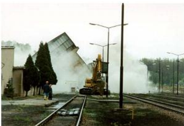
Abb. 6: Sprengung Erzverladebunker Rottwerndorf (Standort Königstein) und die sanierte Betriebsfläche
