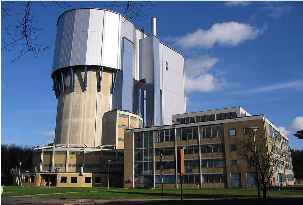
Abbildung D-22: Anbau der Materialschleuse an das Reaktorgebäude des AVR (Bildrechte: EWN)
