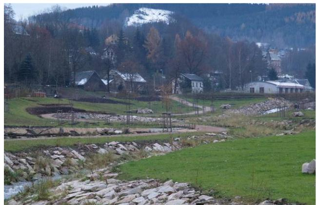
Abb. 6: Sanierung eines Tagesbruchs bei Schacht 348, Schmiedeberg, ©Archive Wismut GmbH
