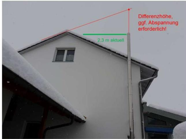
Bild 3: Dachneigung 20°, Abstand zum First: ca. 2 Meter, Schornsteinhöhe über Dach: ca. 3 Meter
