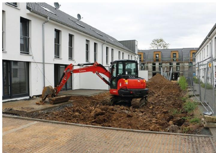
Entsiegelung und Förderung der Bodenkühlleistung: Arbeiten mit einem Minibagger auf einer späteren Grünfläche in einem Neubaugebiet
